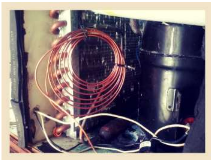
Figura B.3: Sistema de expansão capilar.
