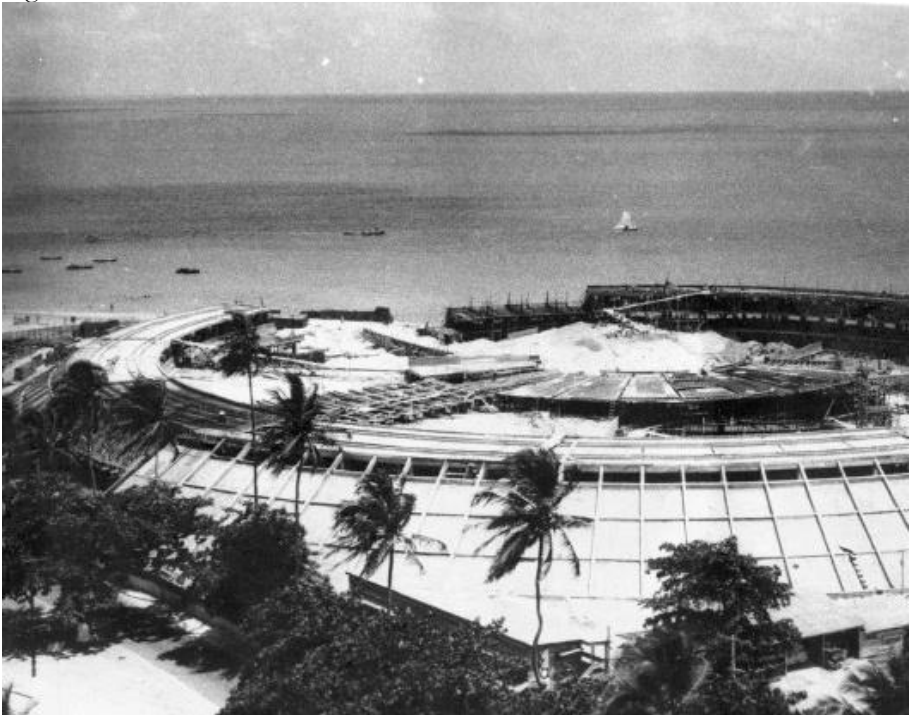
Figura: Obras no Hotel Tambaú
