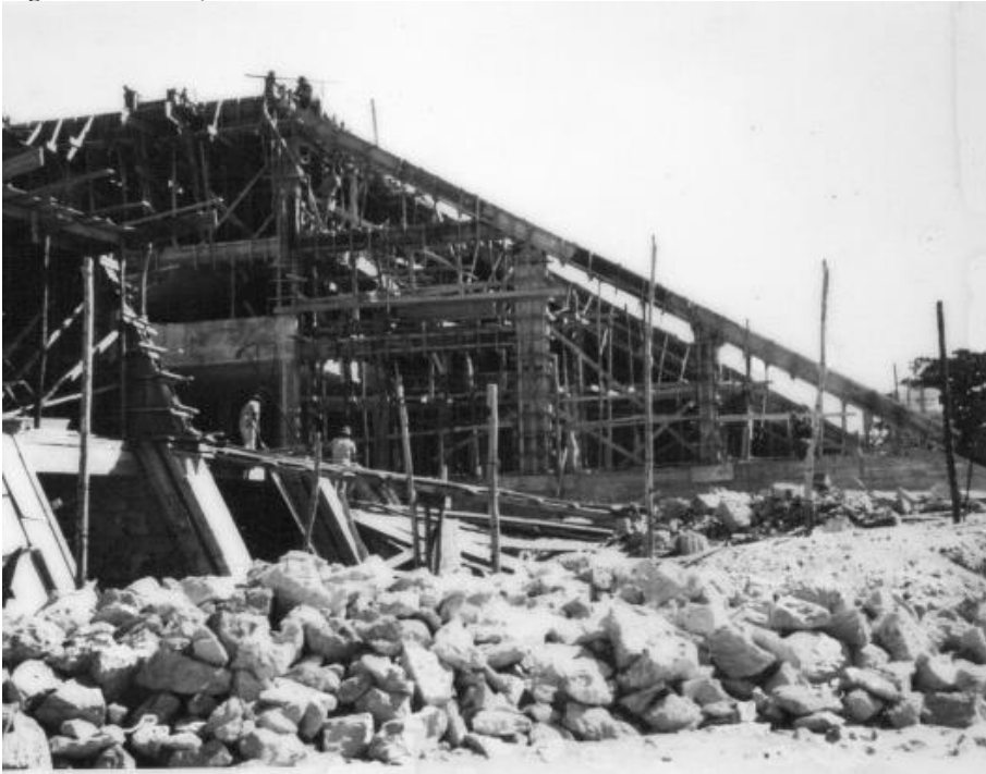
Figura: Construção do Hotel Tambaú
