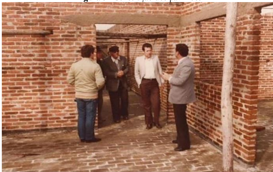
Figura 3 – Construção dos pavilhões
