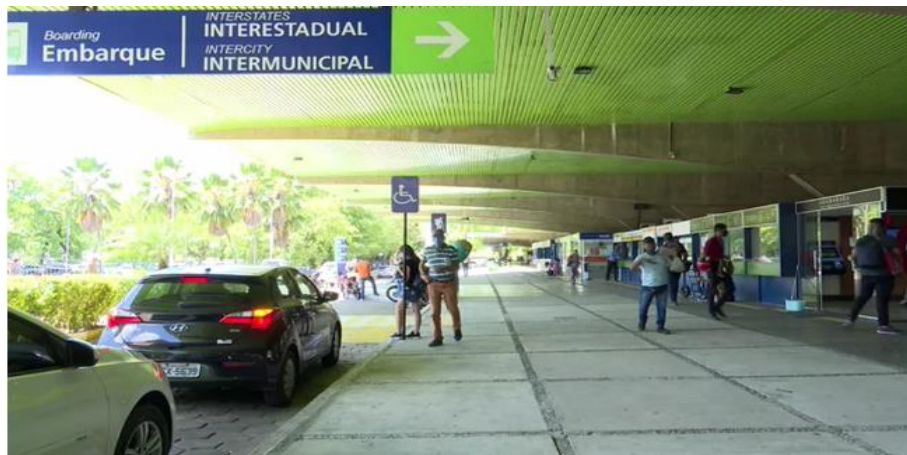
Figura 2: Pátio externo do terminal rodoviário Severino Camelo em João Pessoa-PB.
