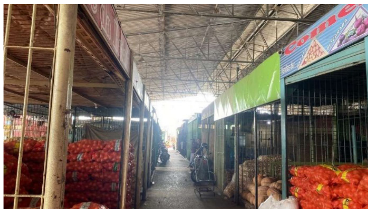
Figura 1 – Boxes do Centro de Abastecimento de Vitória de Santo de Antão
